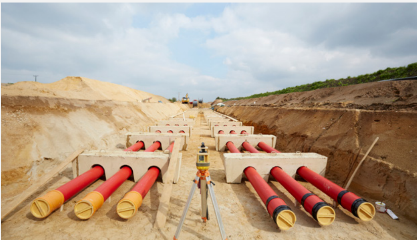
Rhein-Main-Link-hanke. Kuva: Amprion.
